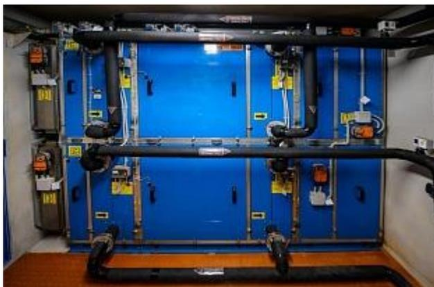
Блок-боксы приточной вентиляции предназначены для создания гарантированного подпора (избыточного давления) в различных зданиях и помещениях заказчика, например в ангарном укрытии и кожухе наддува ГТУ газоперекачивающего агрегата (ГПА).
